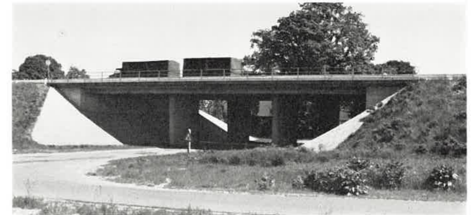
Schlaff bewehrte bzw. vorgespannte Brücken im Zuge der B 70 in Völlenerfehn
