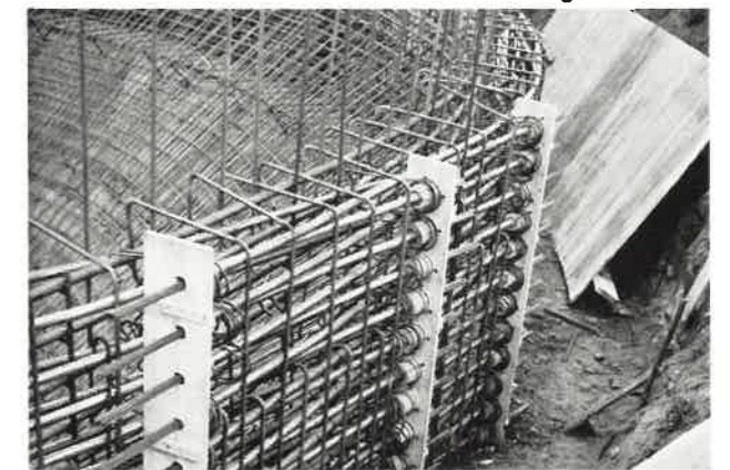
Lisene am Fundamentring der Kläranlage Hameln **
