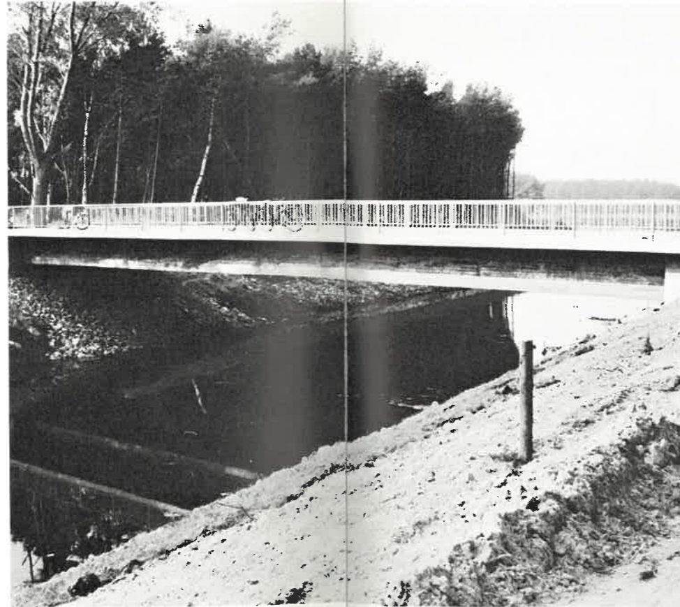
Spannbetonbrücke über die Goldfischdever bei Lehe, Stützweite 32 m
