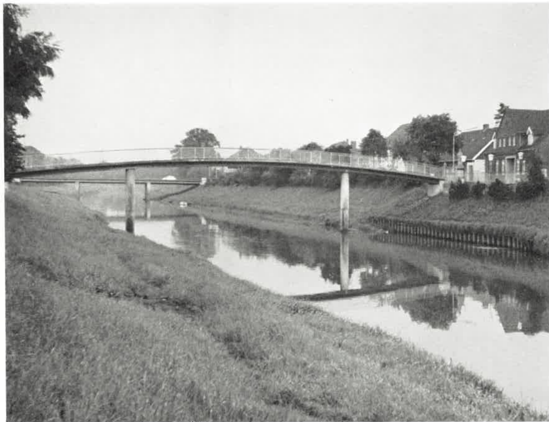
Haseausbau mit Ufersicherung in Herzlake
