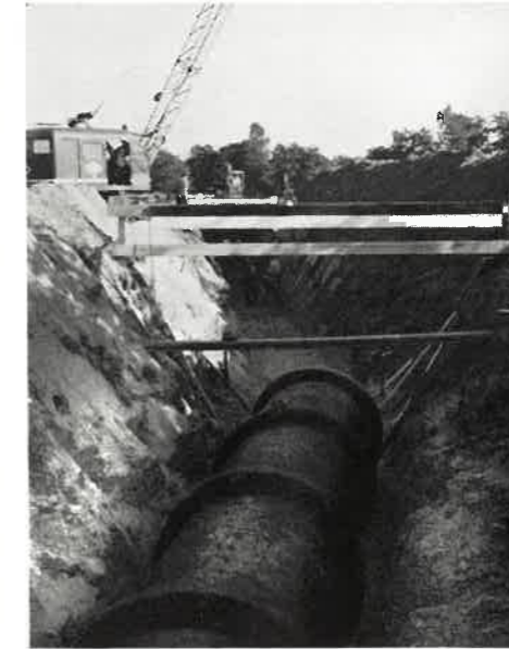
Schmutzwasserkanalisation in Bielefeld-Heepen, Rohrmaterial: Schleuderbetonrohre NW 1200, Kunststoffspirale NW 600, Polyäthylenrohre NW 1000
