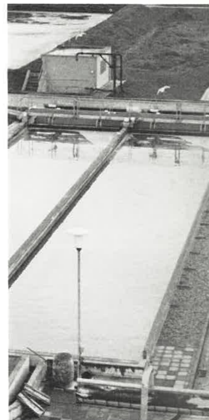
Vorklärbecken der Kläranlage Lingen **
