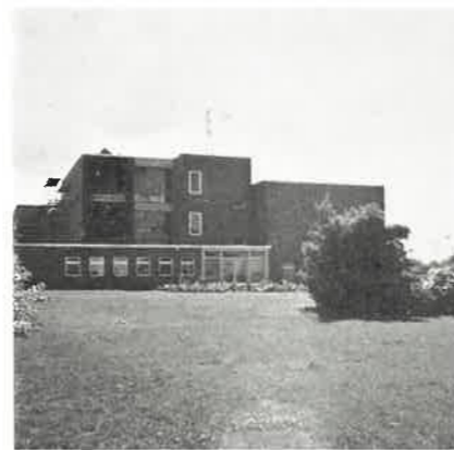
Wasserwerk Haren-Düne, Leistung 350 m 3 /Std.
