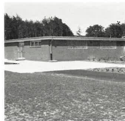
Wasserbehälter in Varloh, I = 2000 m 3
