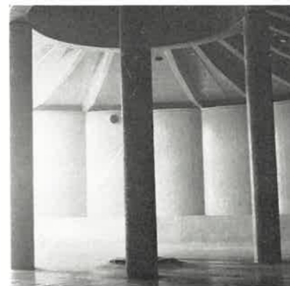
Innenansicht Wasserbehälter in Werpeloh
