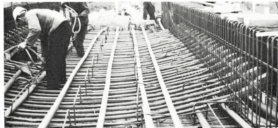
Längs- und Quervorspannung der Bundesbahnbrücke in Neuenkirchen/Westfalen
