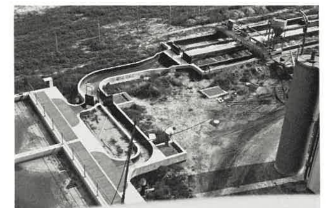
Kläranlage Gifhorn ** Sandfangrinne und Vorklärbecken
