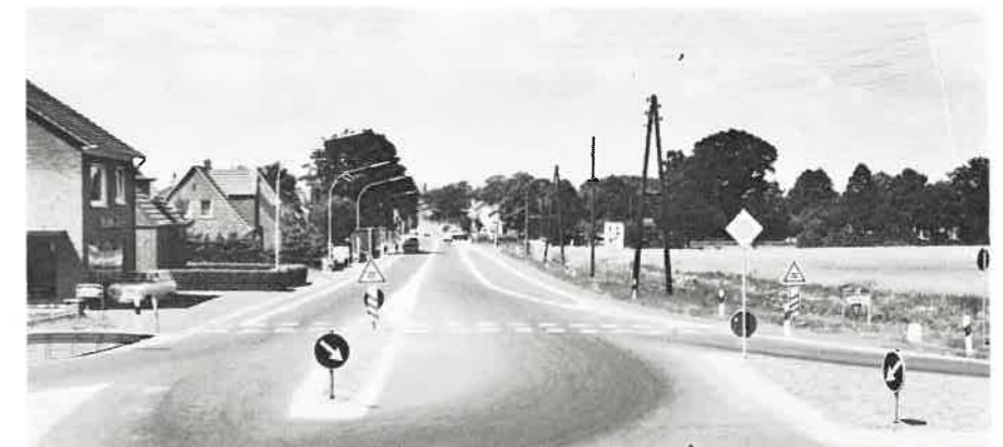
Ausbau der Bundesstraße 402 in der Ortsdurchfahrt Emmeln
