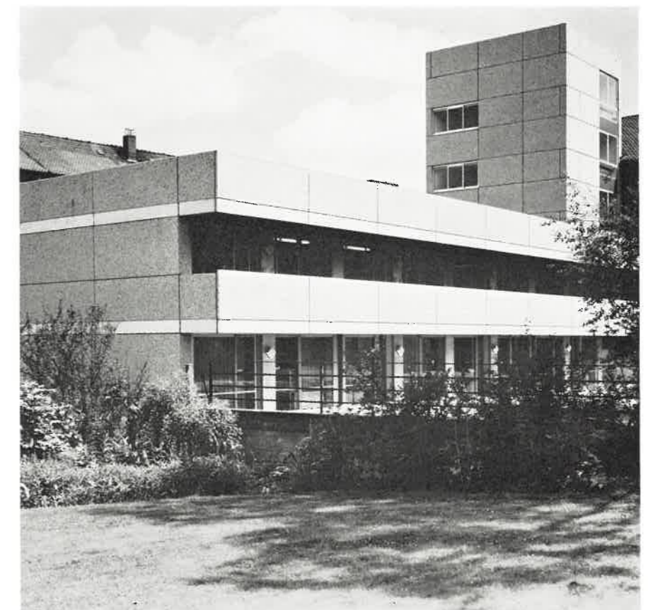
Krankenhaus Meppen, Treppenhaus in Gleitschalung
