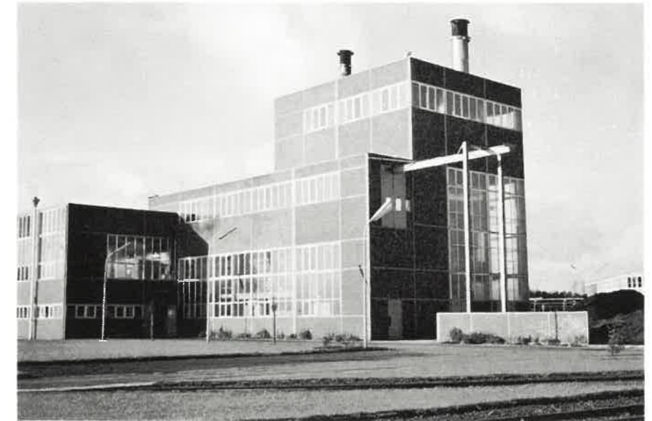
Gewerkschaft Elwerath, Rühlermoor, Turbinen-Kesselhaus
