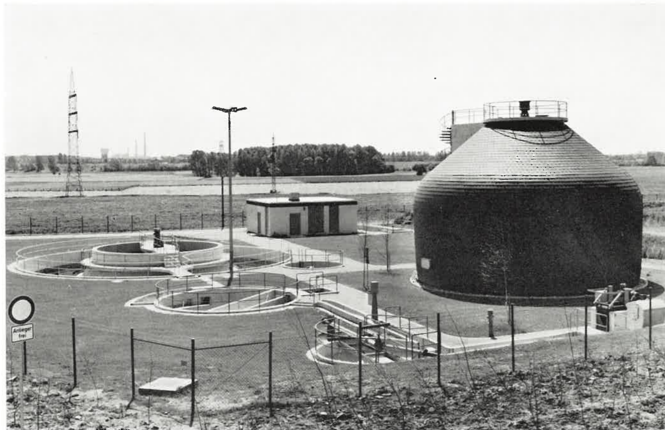
Kläranlage für den Lippeverband in Bockum-Hövel **
