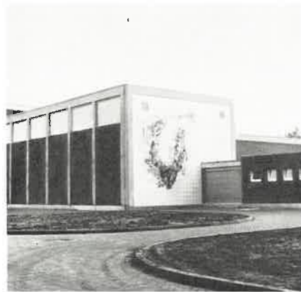
Wasserwerk Werlte, Leistung 350 m 3 /Std.
