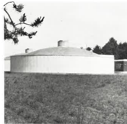
Wasserwerk Darne mit zwei vorgespannten Reinwasserbehältern
