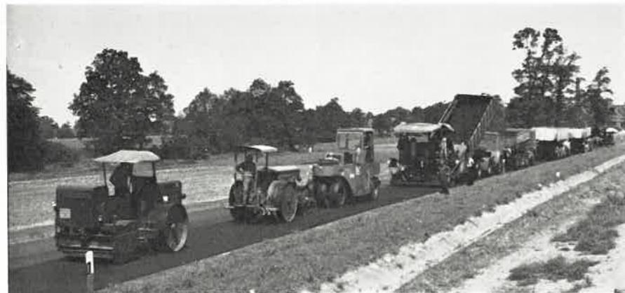
Herstellung der Umgehungsstraße Fullen in der L 48
