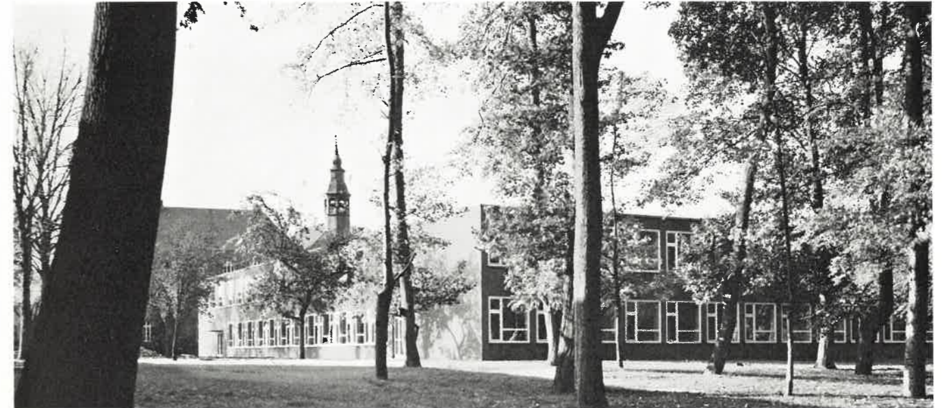
Gymnasium Meppen, 40 000 m 3 umbauter Raum
