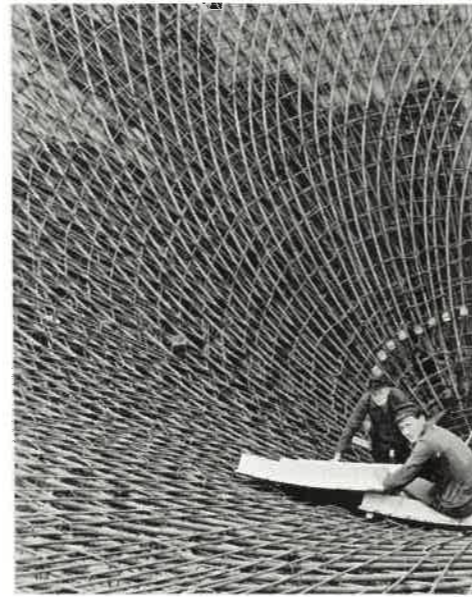
Kläranlage Hamm (Westf.), Spiralbewehrung
