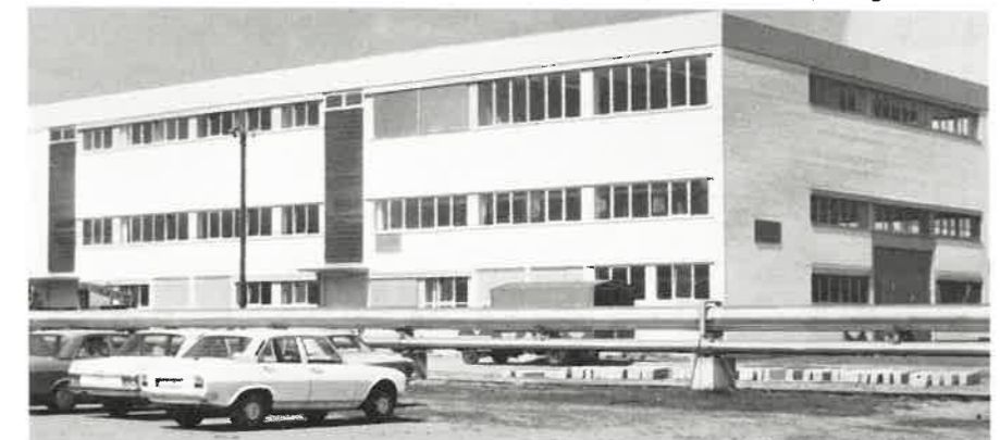
Werkstatt- und Sozialgebäude * VEW-Kraftwerk Emsland Lingen-Darme
