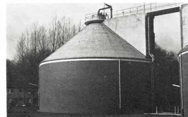
Faulbehälter der Kläranlage Lingen **, 2000 m 3
