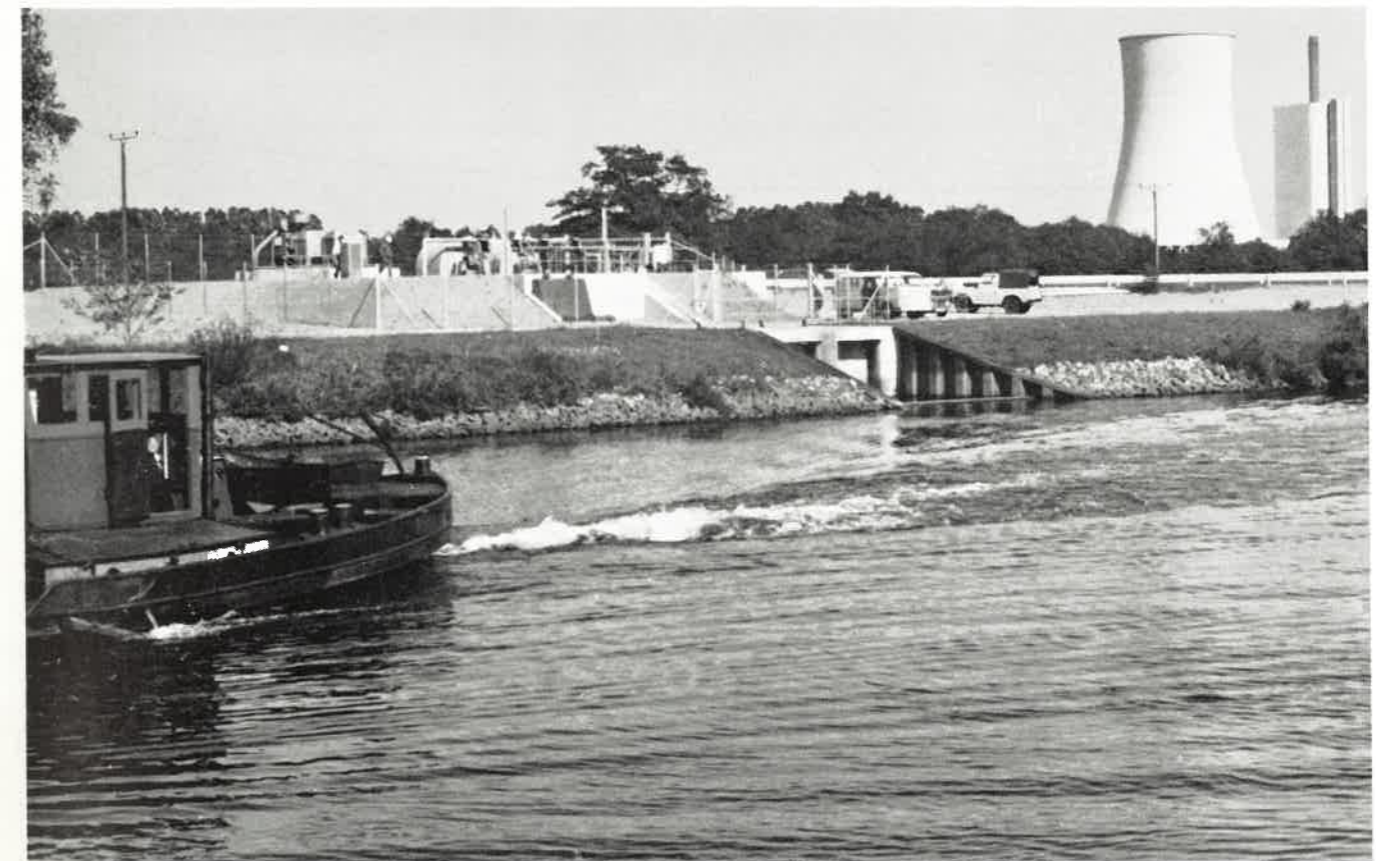
Kühlwasserentnahmebauwerk an der Ems für das 600-MW-Kraftwerk Meppen, Leistung 2600 m 3 /Std.
