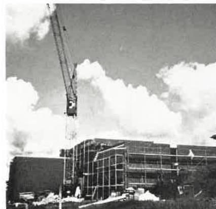
Wasserwerk Haselünne, Leistung 250 m 3 /Std.
