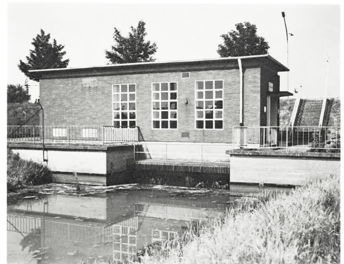
Schöpfwerk im Haren-Landegger- Polder, Leistung 15 000 m 3 /Std.
